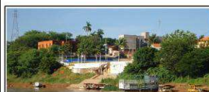
Vista Parcial do Cais Fonte: NUHICRE/IEPHA - MG
