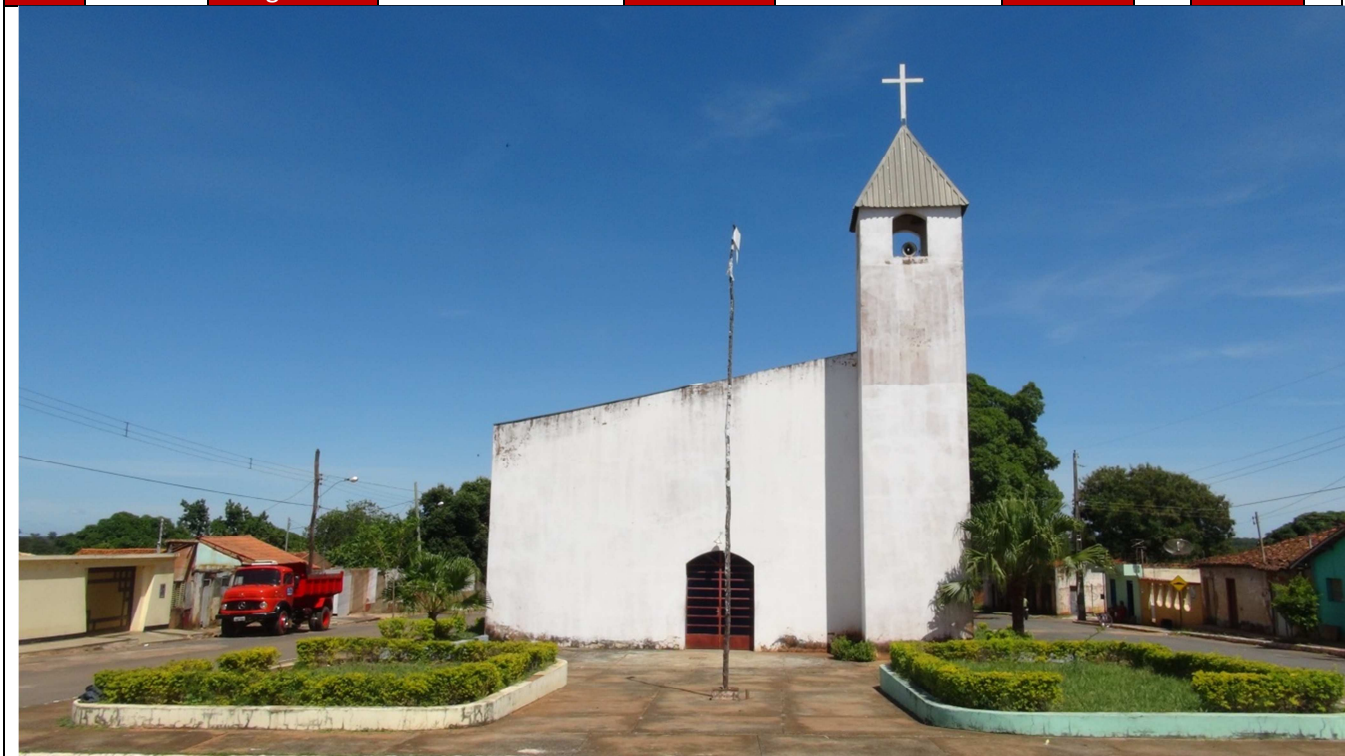
Figura 1: Lateral da Igreja de Nossa Senhora da Conceição.
