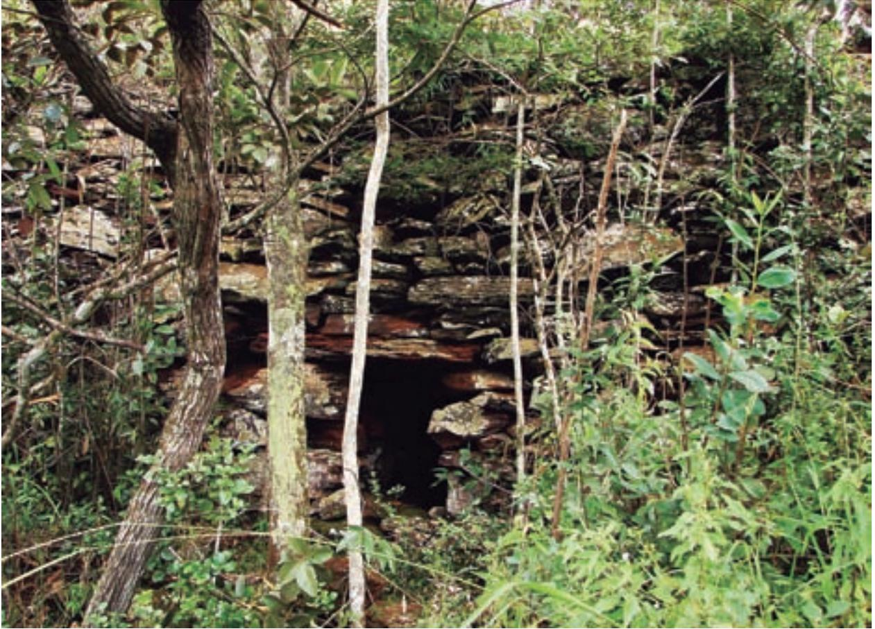
**Figura 17** - Galeria sob estrutura de adução para transposição de drenagem componente do Complexo de Aredes (Itabirito/MG). Foto: Rogério Tobias Junior.
