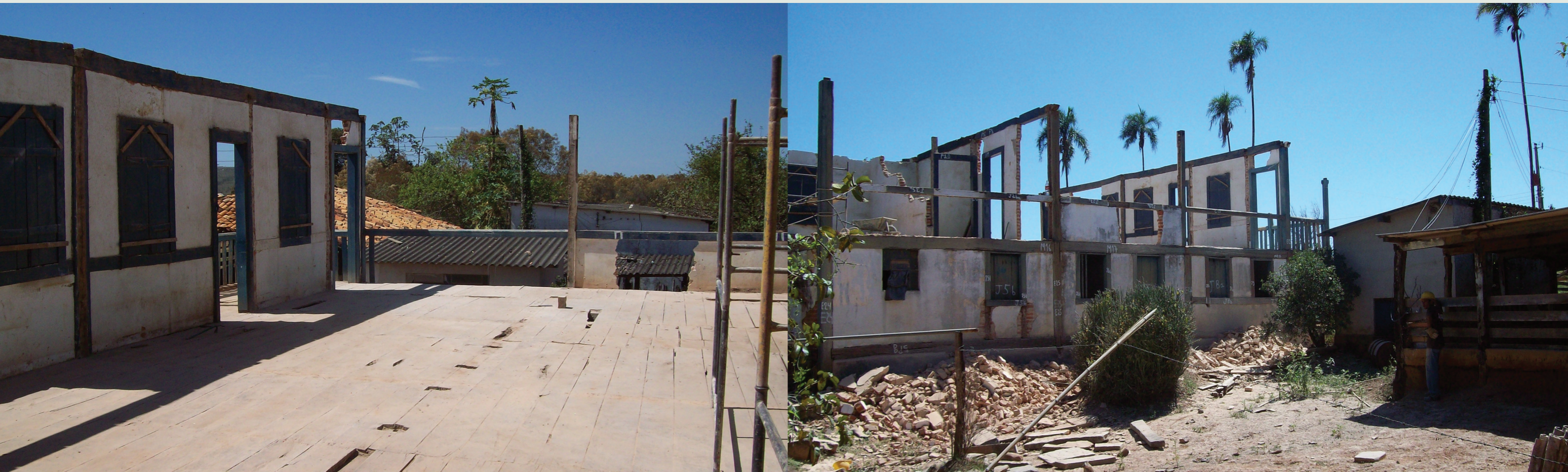
Desmonte da fazendo original em setembro de 2009
