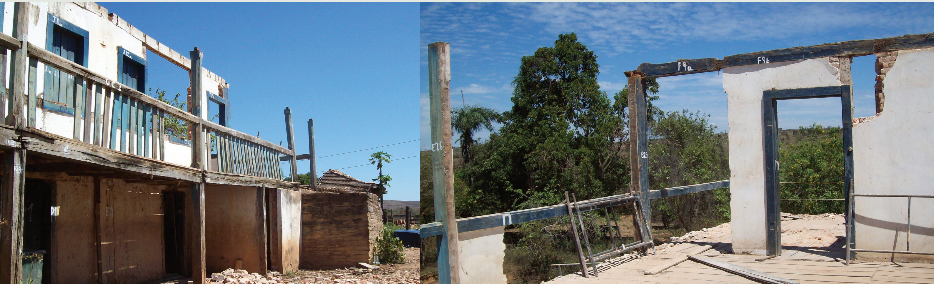
Desmonte da fazendo original em setembro de 2009
