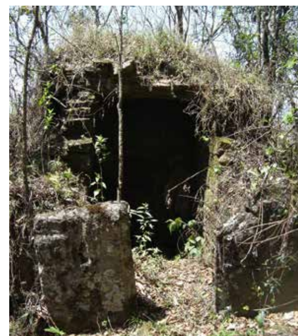
Imagem 80 - Local destinado a armazenamento de produtos controlados. Foto: Henrique Piló.
