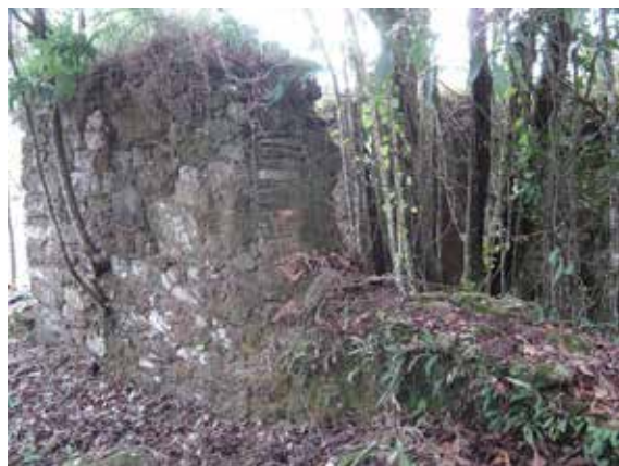
Imagem 21 - Vista lateral da estrutura. Foto Henrique Piló.
