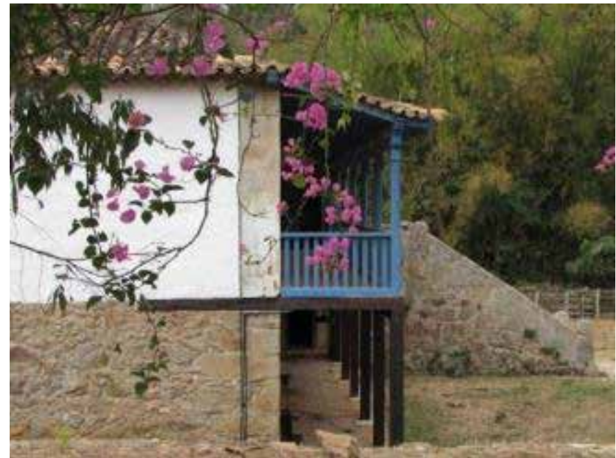
Imagem 4 - Lateral da Fazenda dos Martins com sacada e escada de esteatita. Foto: Alenice Baeta
