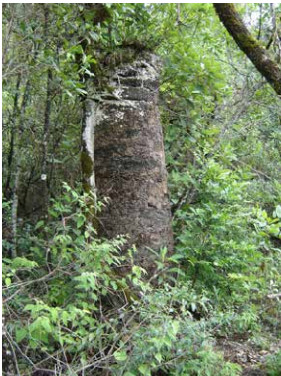
Imagem 53 - Pilar em pedras. Foto: Henrique Piló.
