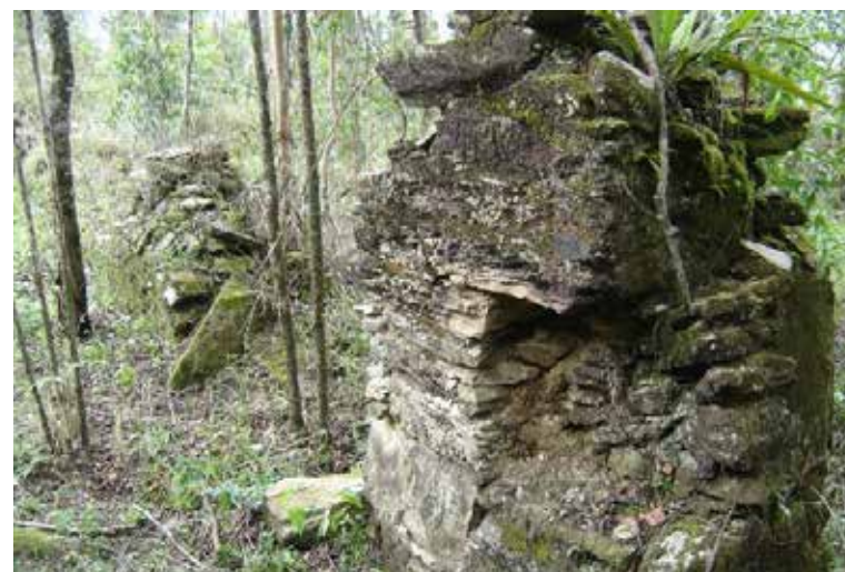
Imagem 23 - Vista de Porta lateral da estrutura. Foto: Henrique Piló.
