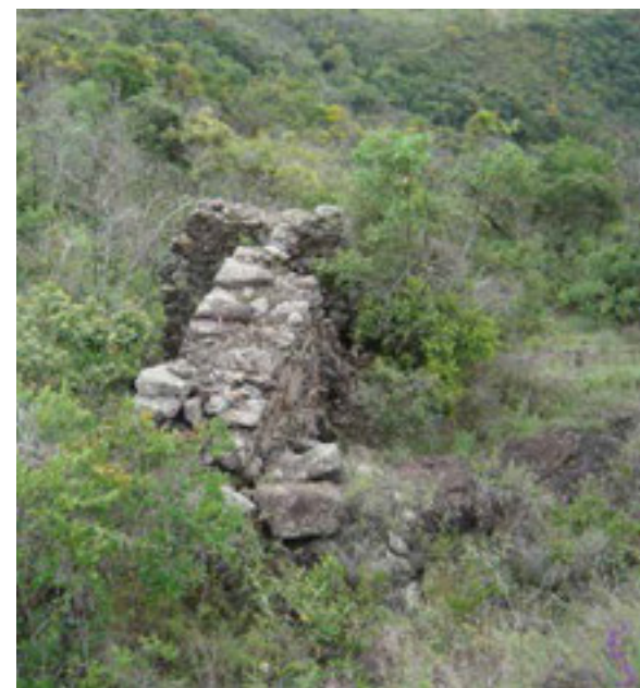
Imagem 57 - Vista geral de onde existia a barragem. Foto: Henrique Piló.
