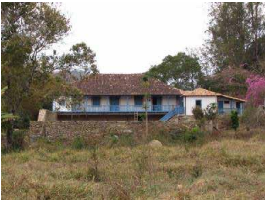
Imagem 3- Fachada oposta da Fazenda dos Martins com cômodo lateral e pátio calçado. No primeiro pavimento local indicado como senzala. Foto: Alenice Baeta
