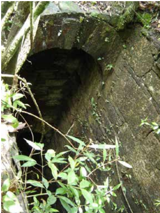
Imagem 52 - Local onde a água era escoada, no encaixe da roda. Foto: Henrique Piló.
