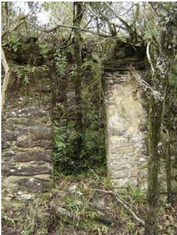
Imagem30 - Detalhe da porta lateral. Foto: Henrique Piló.
