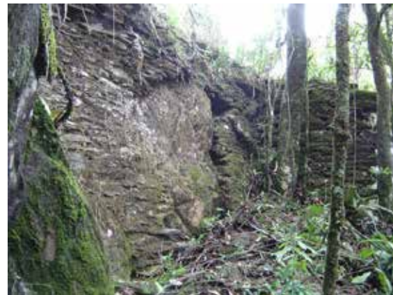
Imagem 49 - Vista da área interna da estrutura. Foto: Henrique Piló.
