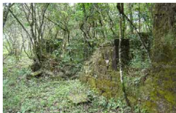
Imagem 17 - Vista geral de fachada com parte desmoronada. Foto: Henrique Piló.
