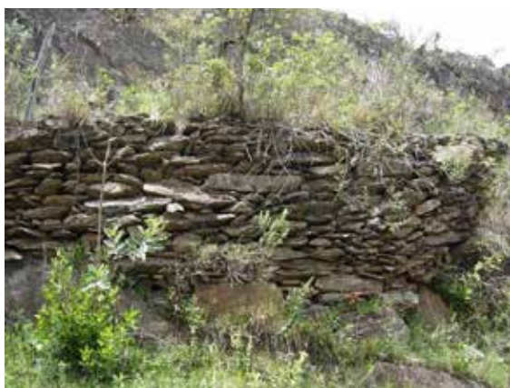
Imagem 88 - Detalhe de trecho de canal no sítio Cata Branca com escoros de alvenaria de pedra. Foto: Henrique Piló.
