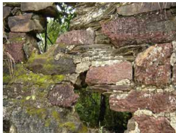
Imagem 36 - Detalhe da parede acima do forno. Foto: Henrique Piló.
