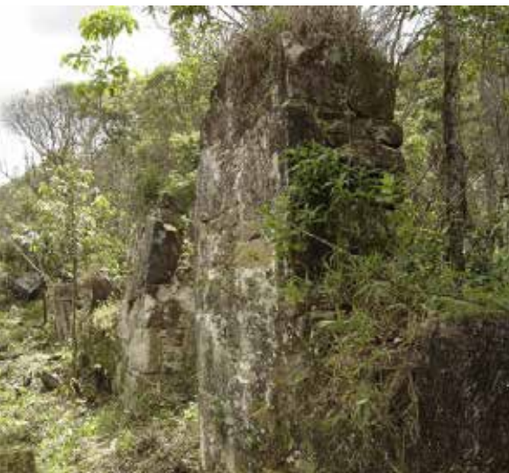
Imagem 25 - Vista geral da estrutura. Foto: Henrique Piló.
