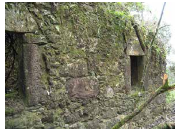
Imagem 28 - Vista da parede lateral e suas janelas. Foto: Henrique Piló.
