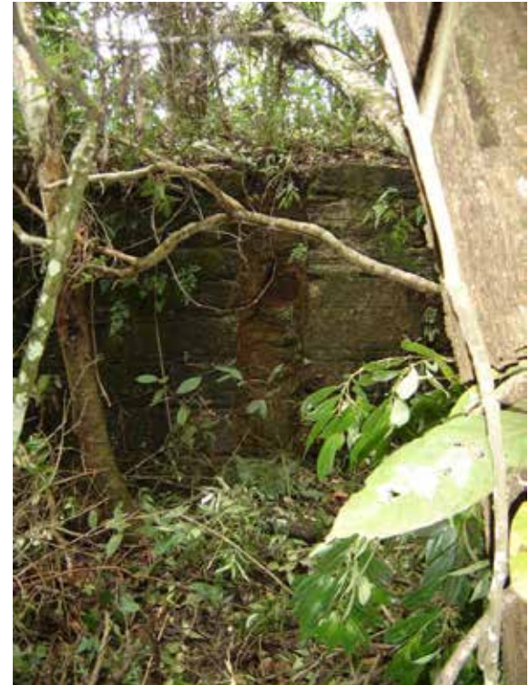
Imagem 50 - Detalhe do local onde se encaixava o dormente da roda d'água. Foto: Henrique Piló.
