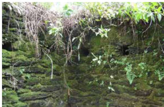
Imagem 16 - Detalhe de orifícios nas paredes evidenciando possível forro. Foto: Henrique Piló.
