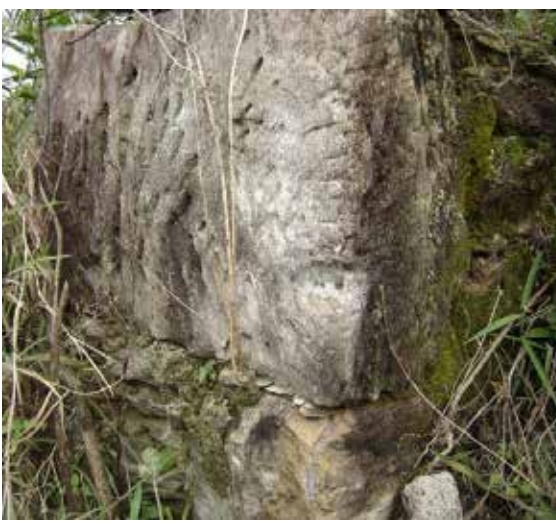
Imagem 27 - Detalhe de marcas de ponteiro regularizando os blocos. Foto: Henrique Piló.
