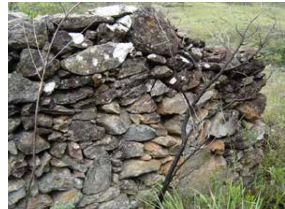
Imagem 45 - Detalhe de parede lateral. Foto: Henrique Piló
