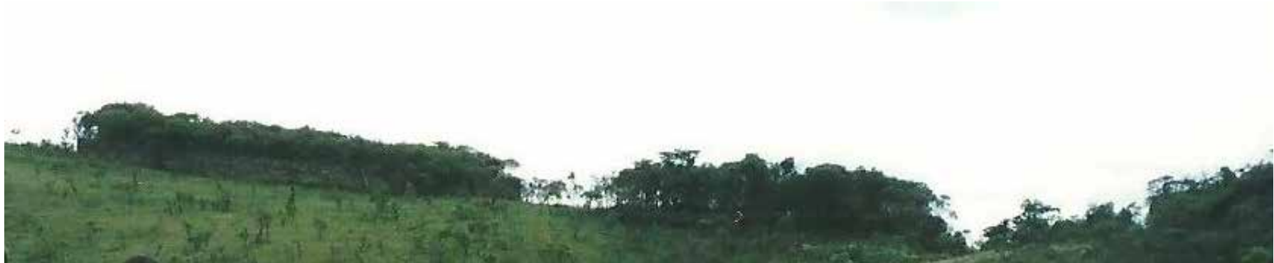
Imagem 16 - Perfil lateral do Forte de Brumadinho: ele é a construção à esquerda. A mata na frente é um conjunto de reservatórios e alicerces. O espaço à direita é a drenagem profunda, onde haveria uma ponte que não mais existe e que exige um desvio para o fundo dessa foto (para o Norte), descendo e subindo a drenagem oposta, para acessar o forte. Para a direita da foto há a trilha em aclave, calçada em pedras, que dá acesso à linha de crista. Foto: Marcus Neves
