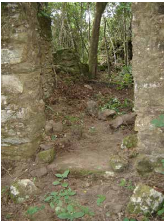
Imagem 11 - Principal acesso à estrutura. Foto: Henrique Piló.
