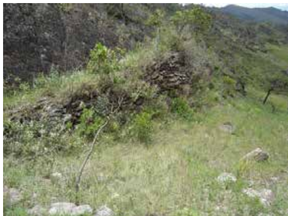
Imagem 87- Trecho de canal no sítio Cata Branca com escoros de alvenaria de pedra. Foto: Henrique Piló.
