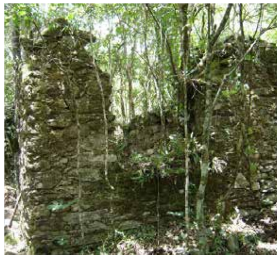
Imagem 13 - Vista geral da parede lateral da estrutura. Foto: Henrique Piló.
