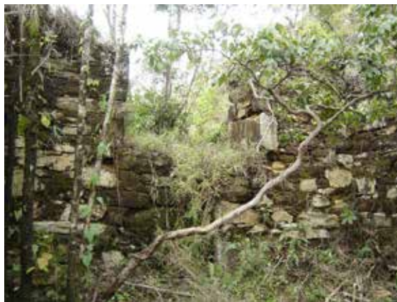
Imagem 61 - Vista do interior da estrutura. Foto: Henrique Piló.
