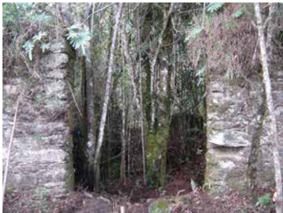
Imagem 20 - Entrada principal da estrutura. Foto Henrique Piló.
