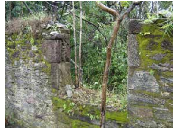
Imagem 38 - Detalhe de janela. Foto: Henrique Piló.
