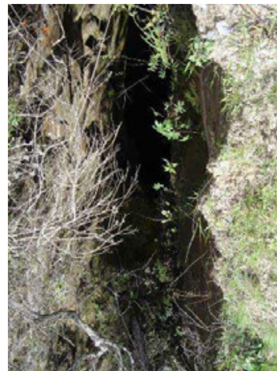
Imagem 90 - Detalhe de entrada de uma galeria. Sítio Cata Branca. Foto: Henrique Piló.
