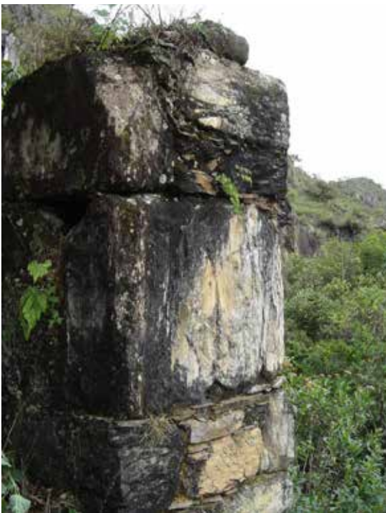
Imagem 62 - Parede lateral da estrutura. Foto: Henrique Piló.
