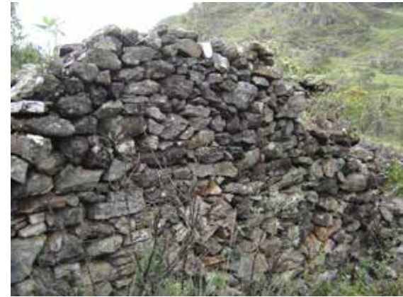
Imagem 44 - Parede lateral em pedras empilhadas. Foto: Henrique Piló
