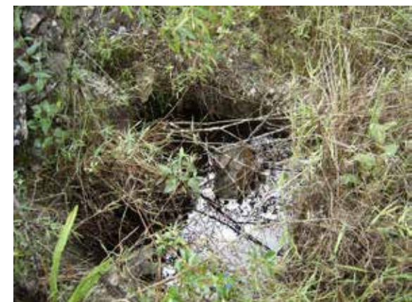
Imagem 46: - Mundêu no interior da estrutura.
