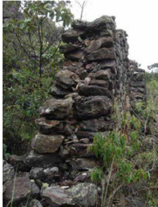
Imagem 42 - Parede lateral da estrutura. Foto: Henrique Piló.
