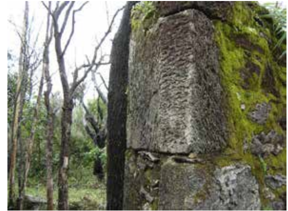
Imagem 37 - Detalhe de bloco com marcas de ponteiro. Foto: Henrique Piló.
