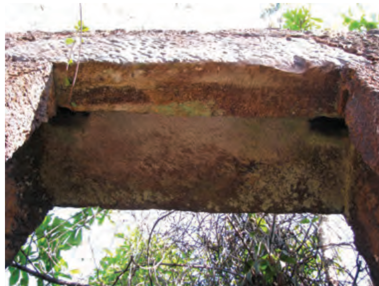
Imagem 20 - Detalhe de bloco de canga esculpida, onde era assentada janela na parede frontal. Foto: Henrique Piló
