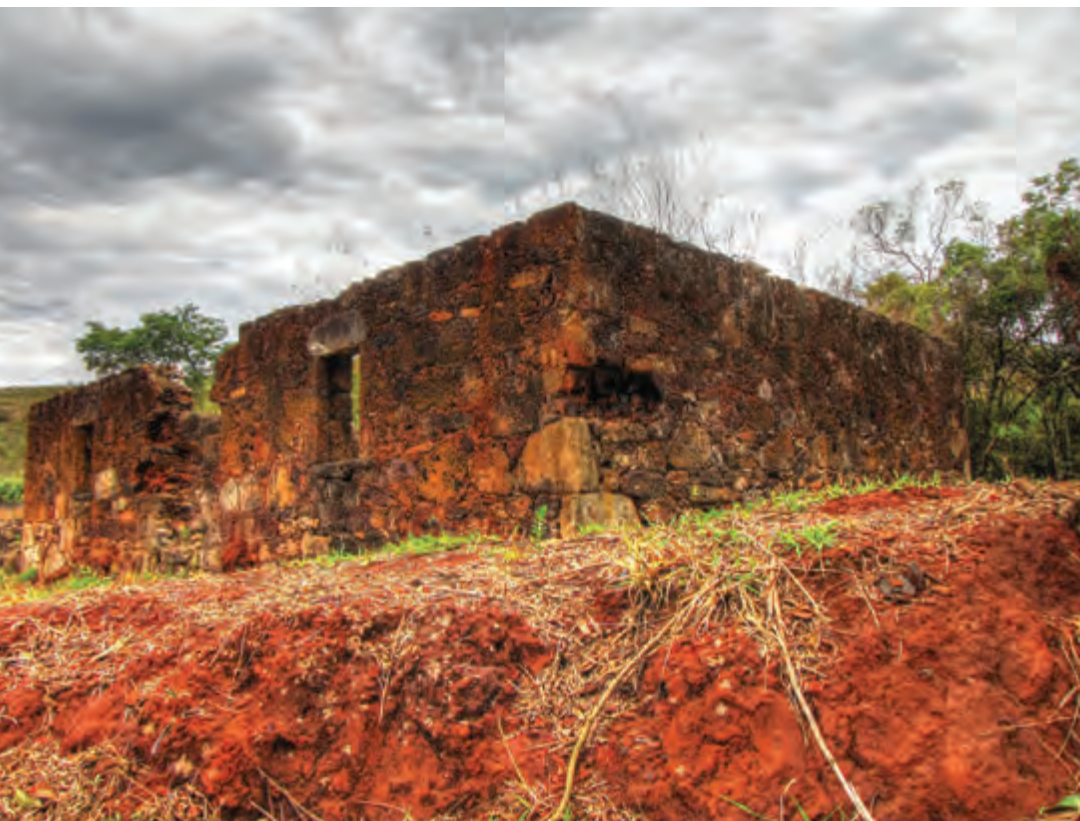
Figura 37 - Vista geral da fachada frontal. Foto: Emile Scharlé Jr. (2014)
