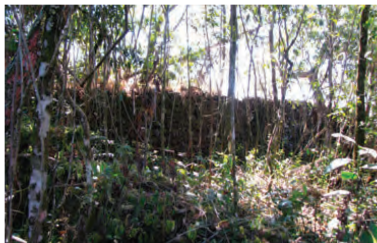
Imagem 46- Vista geral de um dos muros. Foto: Henrique Piló.
