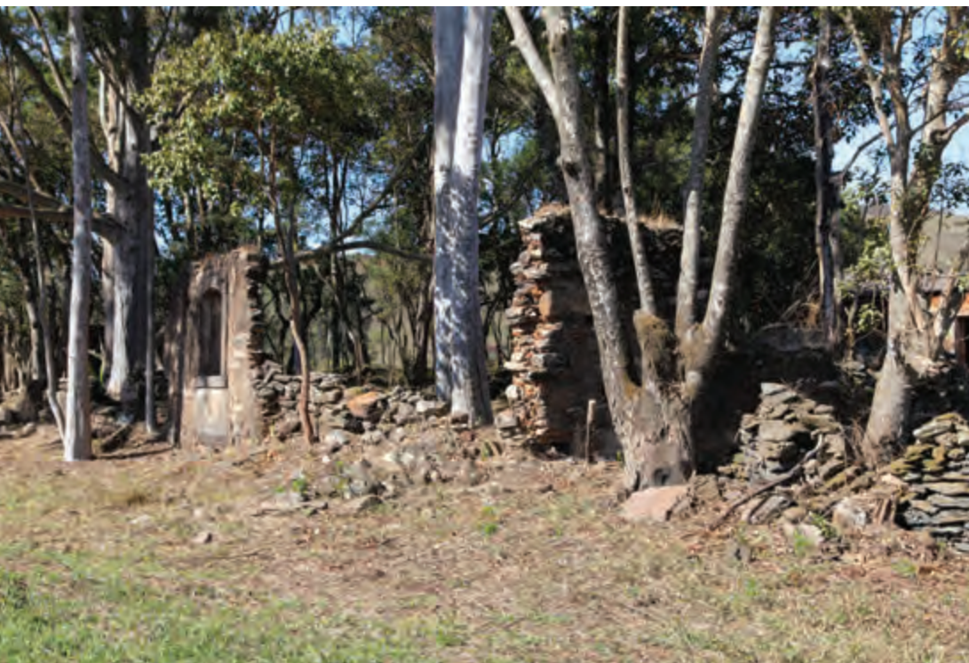
Figura 4 - Vista geral da fachada principal da residência do Conjunto 1. Foto: Pedro Israel de Paiva (2014)
