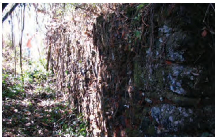
Imagem 45- Vista lateral de um dos muros que formam o conjunto. Foto: Henrique Piló.
