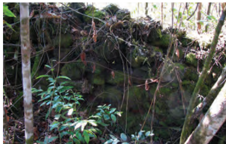
Imagem 47- Vista em detalhes do muro 4. Foto: Henrique Piló.
