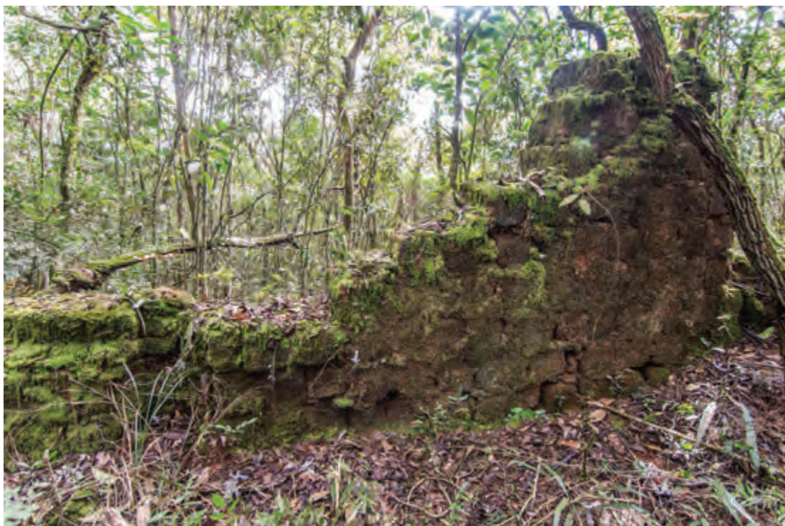
Imagem 25 - Vista de parede remanescente da habitação. Foto: Henrique Piló.
