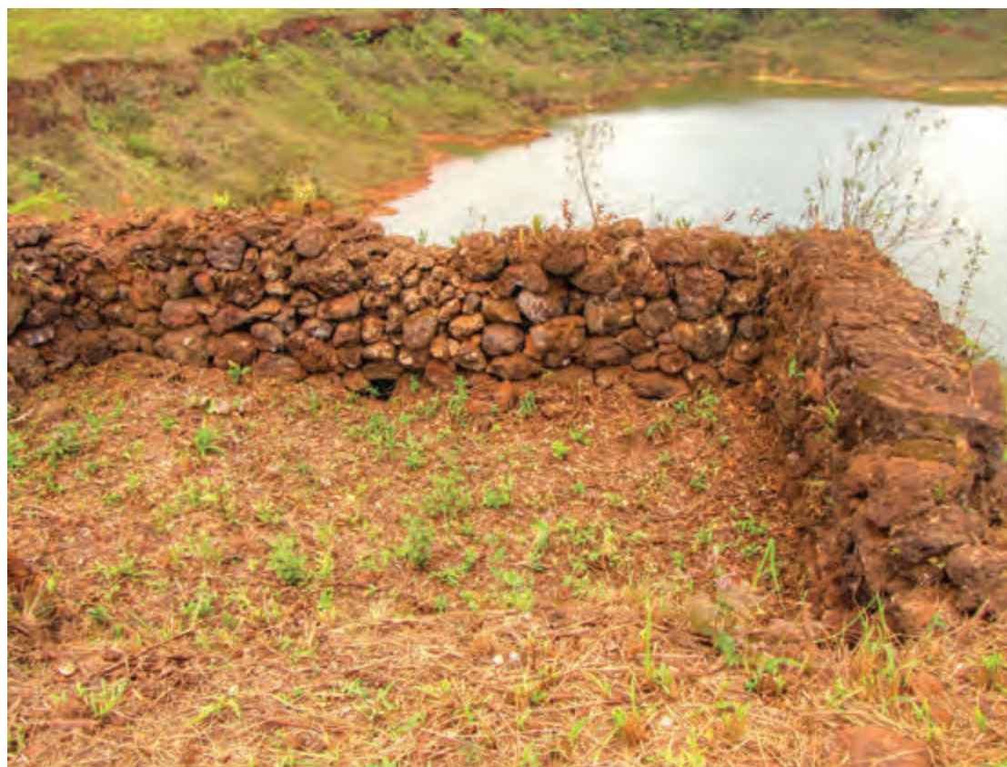
Imagem 22 - Vista de muro lateral da estrutura. Ao fundo área de antiga cata onde se inserem diversos canais. Foto: Henrique Piló.
