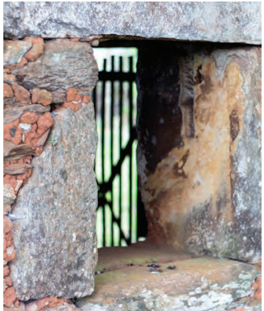
Figura 25 - Detalhe do vão de janela na lateral direita observando os entalhes na ombreira e peitoril para encaixe da esquadria de vedação. Foto: Pedro Israel de Paiva (2014)
