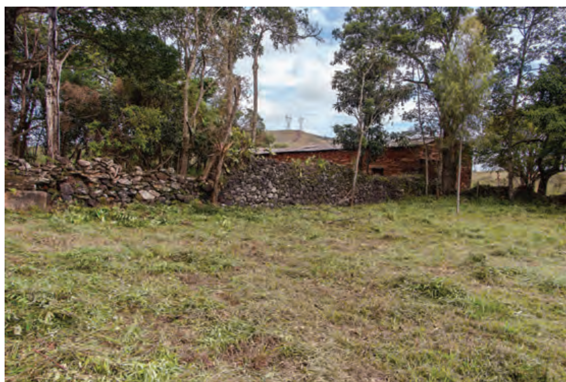
Figura 13 - Vista parcial da área interna do curral, observando muro divisório com a edificação dita como senzala ao fundo. Foto: Henrique Piló (2016).
