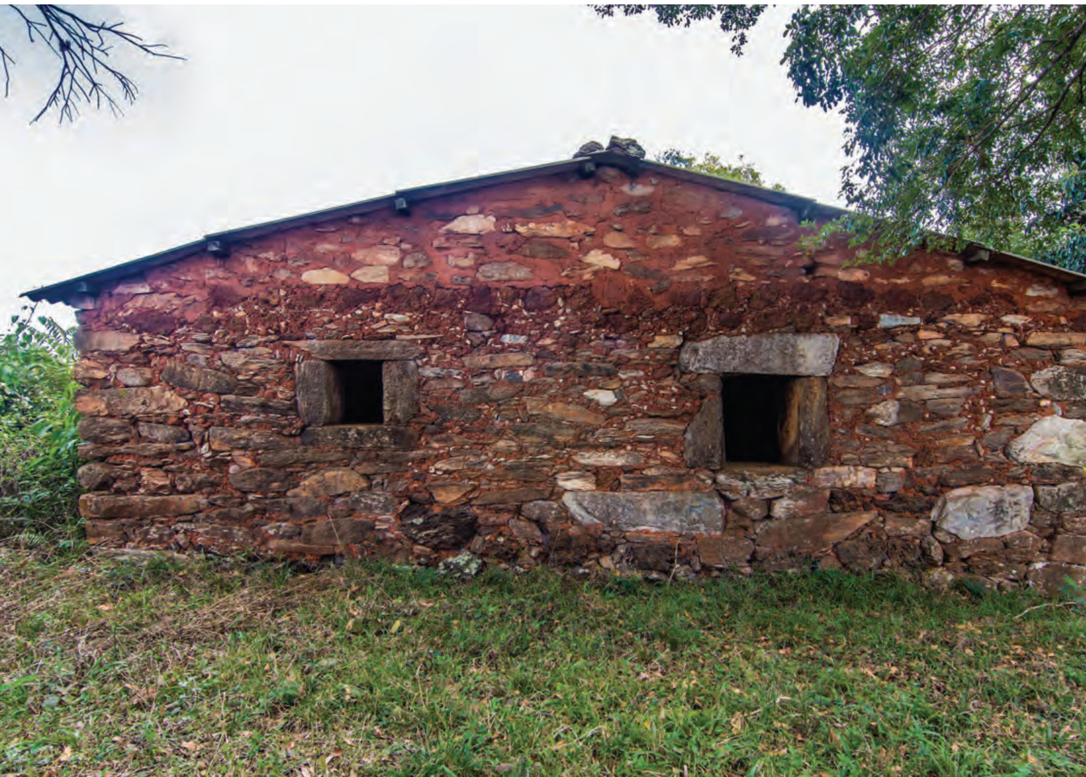
Figura 26 - Fachada lateral direita. Foto: Henrique Piló (2016)
