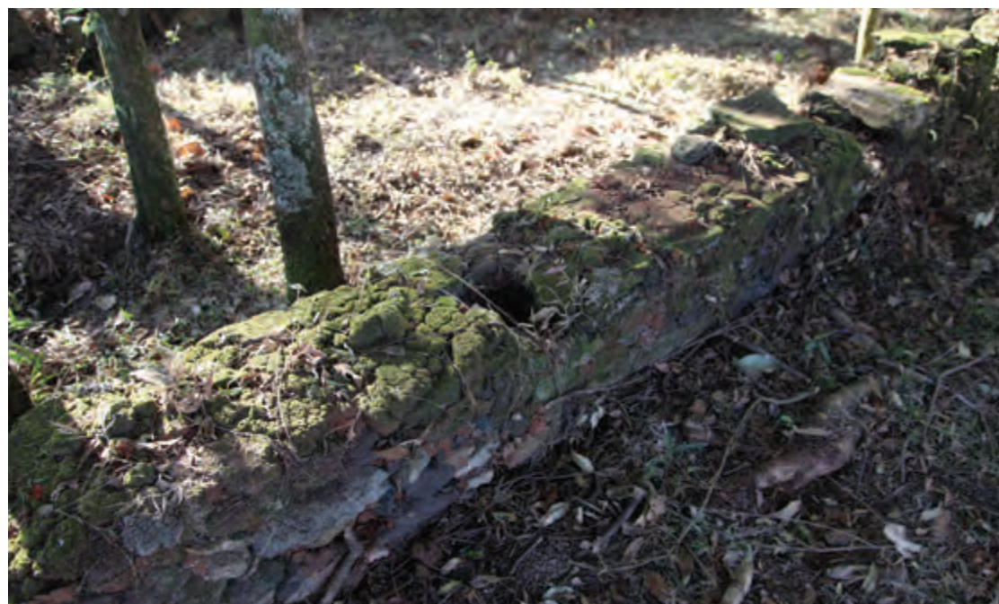
Figura 9 - Baldrame em pedra com orifícios para o encaixe dos esteios da estrutura autônoma de madeira. Foto: Cristina Cairo (2015).
