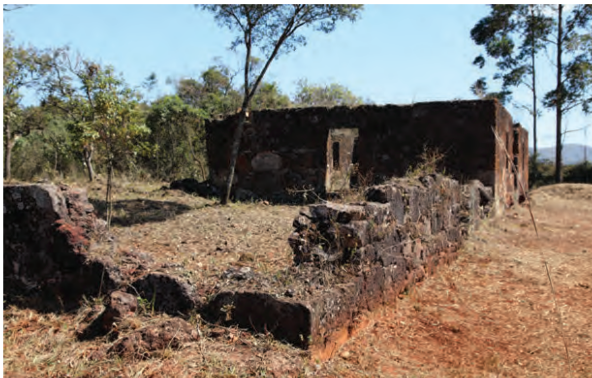
Figura 39 - Vista geral da lateral Direita. Foto: Pedro Israel de Paiva (2014)
