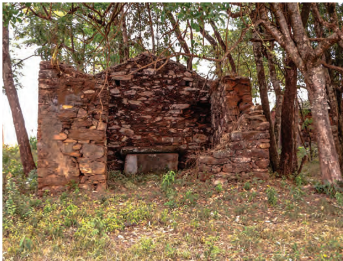
Imagem 9 - Vista geral da capela. Foto: Emile Scharlé Jr.
