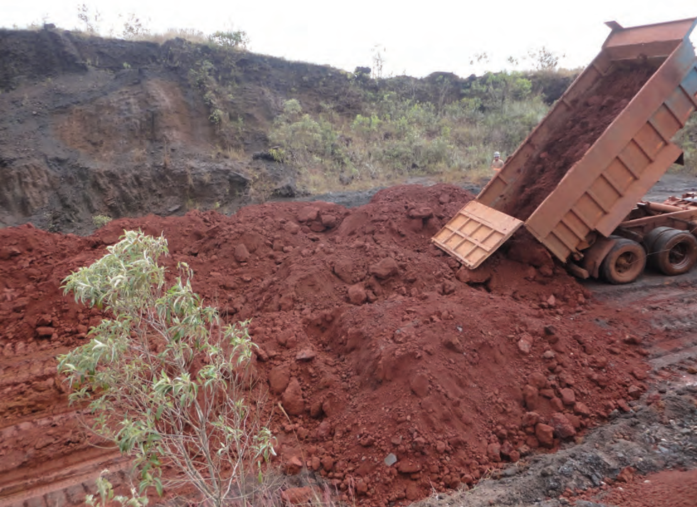
Imagem 6 - Início do processo de preenchimento da Cava Oeste. Fonte: Arquivo Fotográfico SAFM Mineração.
