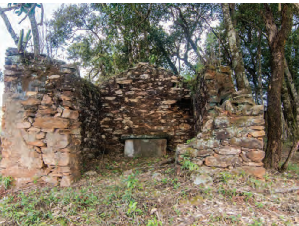
Figura 18 - Fachada frontal, voltada para nordeste, observando ao fundo, o pano de alvenaria que recebia o altar. Foto: Henrique Piló (2016).
