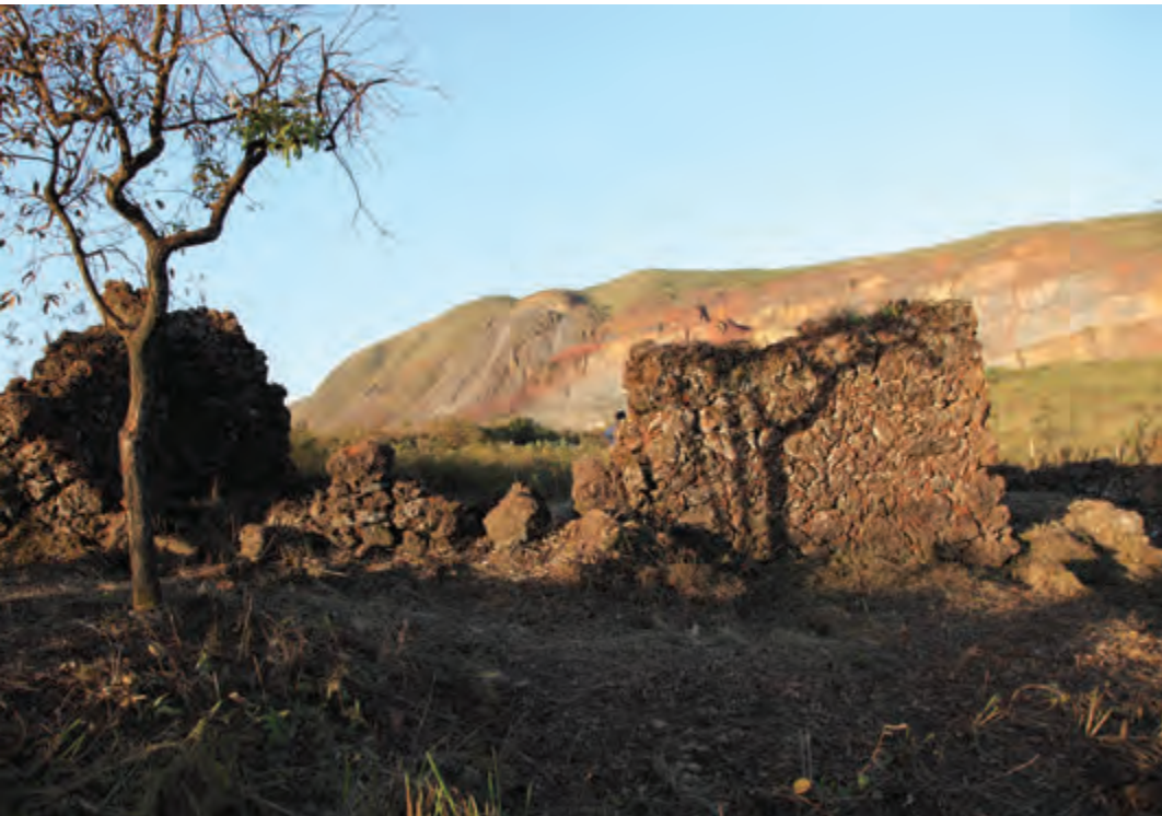
Figura 31 – Vista geral da face voltada para oeste. Foto: Pedro Israel de Paiva (2014)
