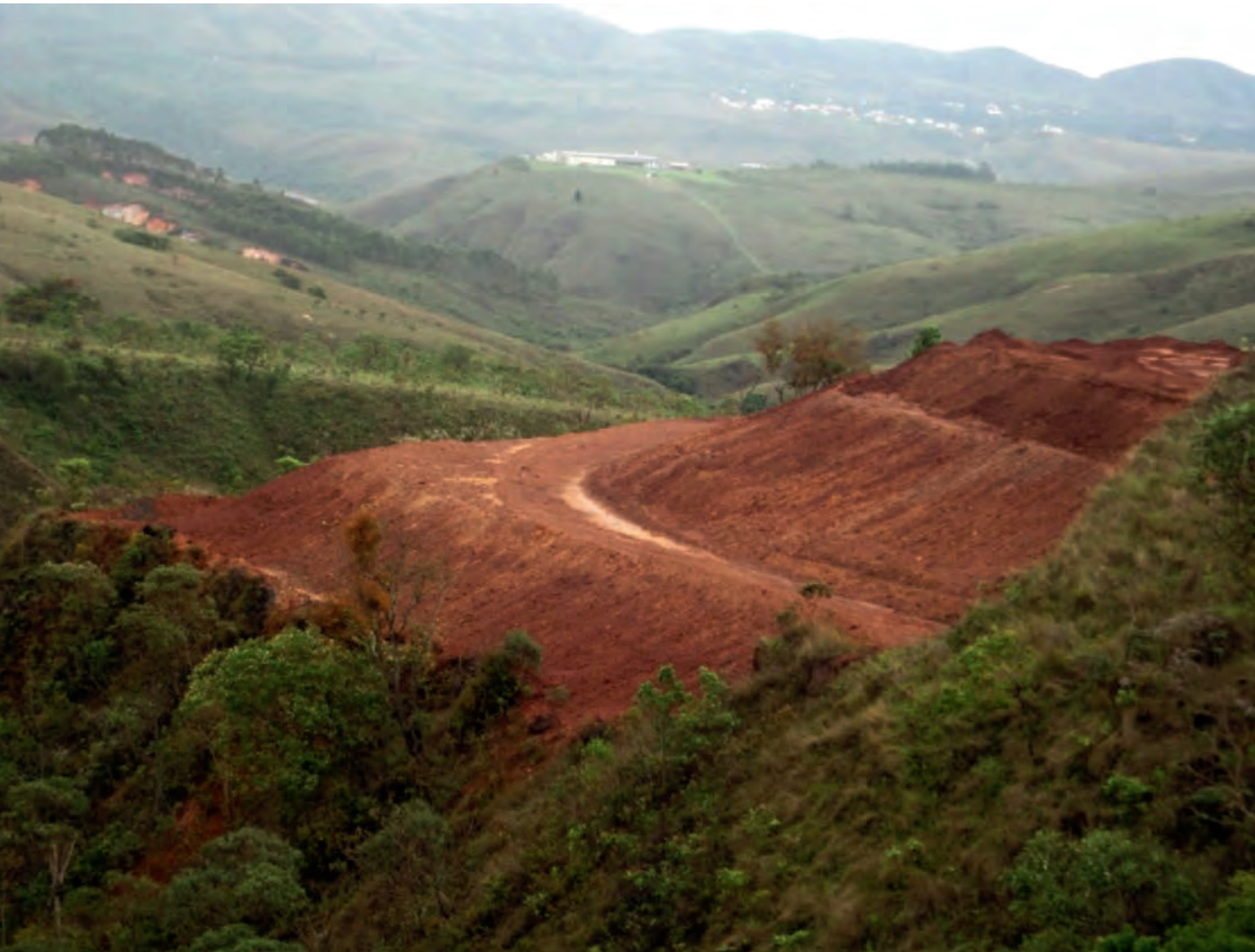
Imagem 7 - Finalização do processo de preenchimento da Cava Oeste. Fonte: Arquivo Fotográfico SAFM Mineração.
