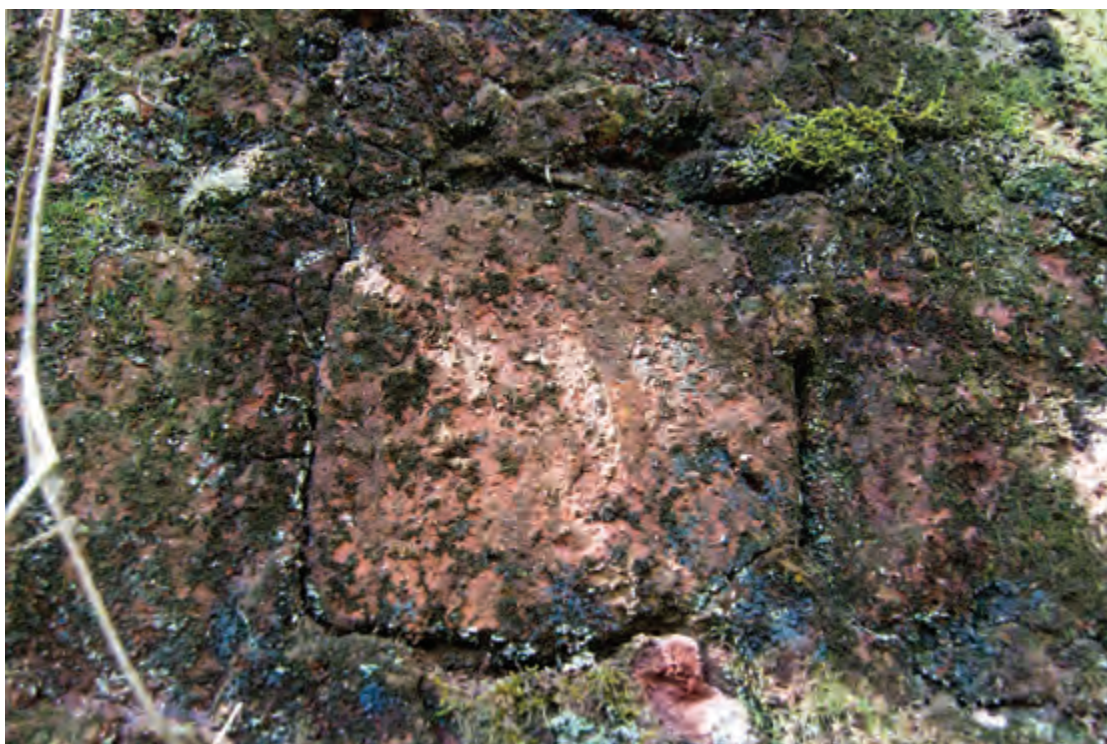
Imagem 27 - Detalhe de adobe compondo a parede. Foto: Henrique Piló
