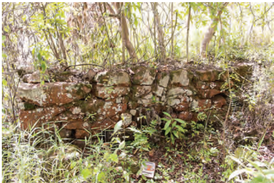
Imagem 40 - Vista em detalhe do alicerce da edificação. Foto: Henrique Piló.
