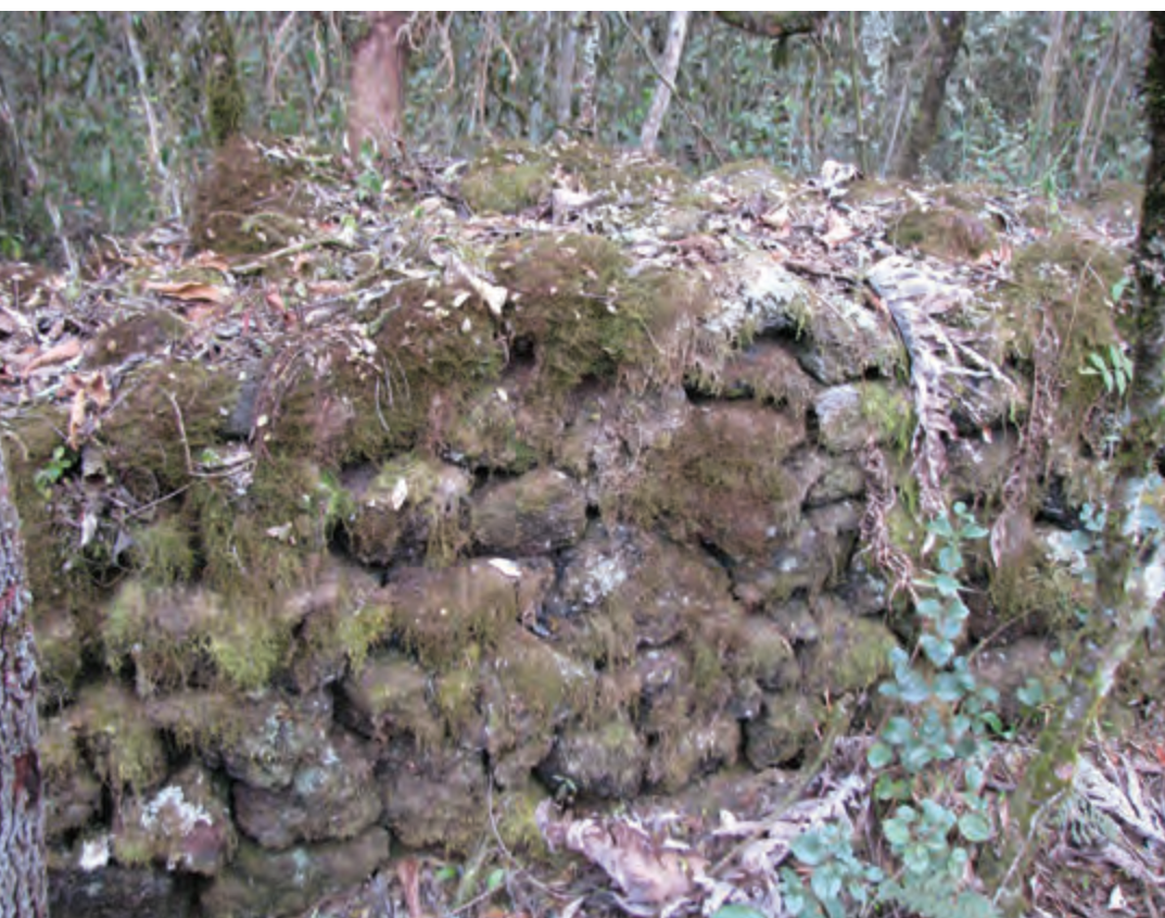
Imagem 43- Vista de parte da parede do mundéu. Foto: Henrique Piló.
