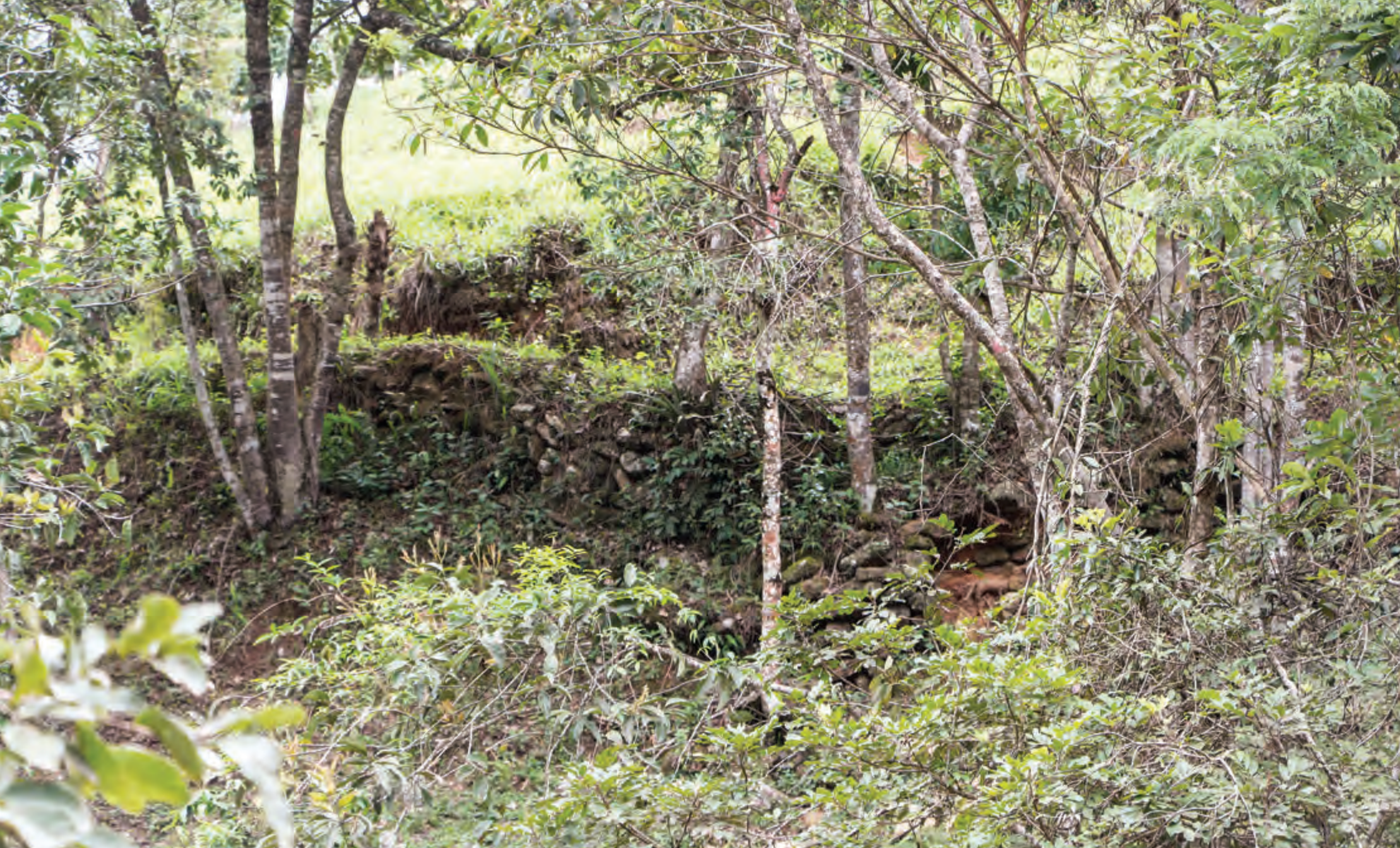
Imagem 3 - Escoramento em barranco na região do Bação. Foto: Henrique Piló.
