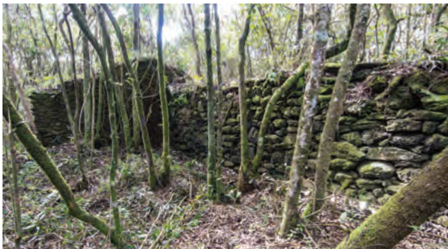
Imagem 31 - Vista do encontro do muro com a unidade de habitação. Foto: Henrique Piló
