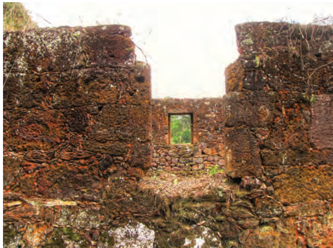
Figura 38 - Detalhe dos vãos da janela. Fachada posterior. Foto: Henrique Piló (2015).
