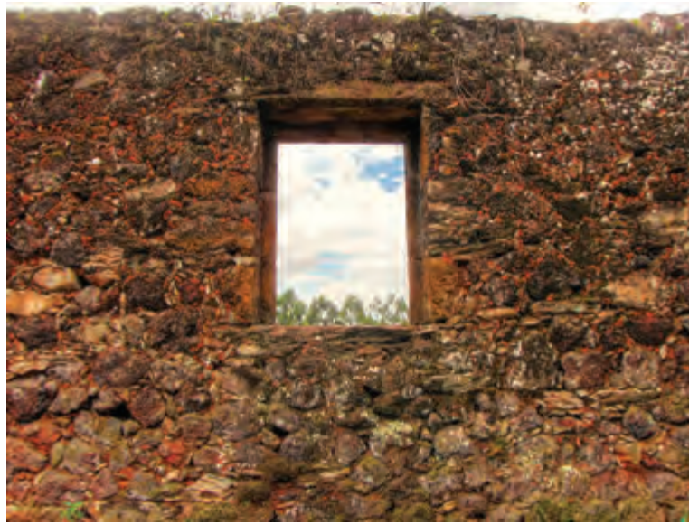
Imagem 19 - Detalhe janela da edificação. Foto: Henrique Piló.
