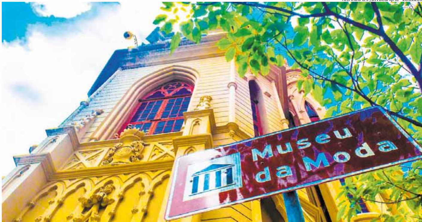
Exemplo. Uma das edificações museológicas do Estado que estariam irregulares é o Museu da Moda, na capital, construído em 1911
