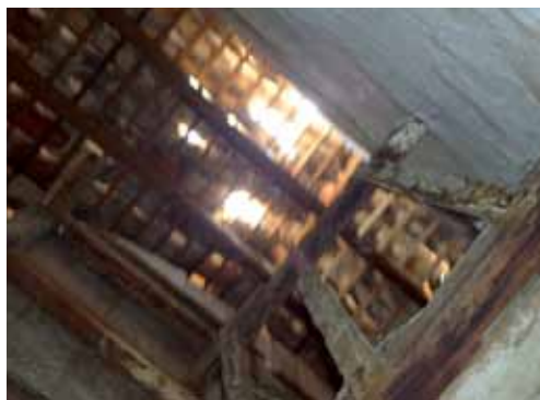
Falta de telhas Fonte: Capela São Francisco de Assis, em Caeté Autor: Andréa Lanna - MPMG
