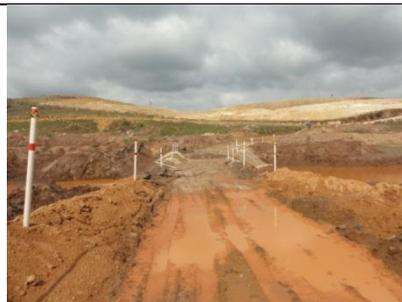
Foto 04: Acesso que será utilizado pelas máquinas que realizarão a retirada do rejeito. UTM WGS84 23K 665949 7761172.
