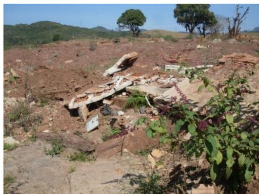
**Foto 4-4: Acúmulo de material construtivo, paredes e ferragens das casas atingidas pela lama. UTM WGS84 23 K 665590 7761384.**
