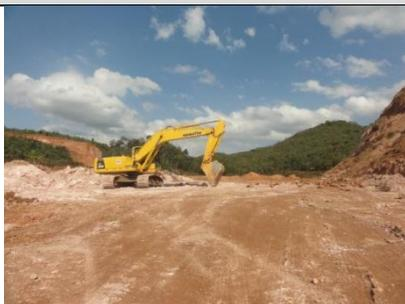
Foto 01: Maquinário realizando a construção de taludes na área do dique S4. UTM WGS84 23K 665914 7761077.
