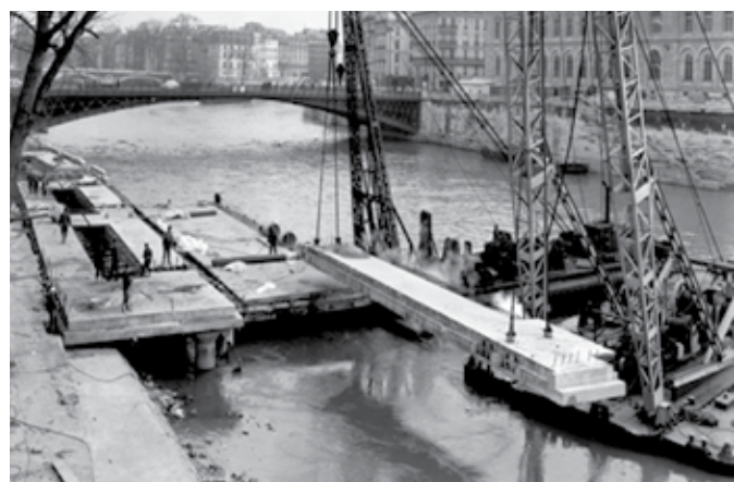
Figura 4: Acima, lazer no rio Sena, século XX. Fonte: < http://bergesdeseine.paris.fr > (As margens do Sena perto do Pont-Neuf . © Roger-Viollet LAPI). Abaixo margens do rio ocupadas por veículos e maquinários, segunda metade do século XX. Fonte: < http://bergesdeseine.paris.fr > (Obras de pavimentação das margens e acima do Sena. © Mairie de Paris DVD. Poster de Savignac para a associação de defesa et de valorização do sítio de Notre-Dame (circa 1971). © Mathieu Flonneau – arquivos particulares).
